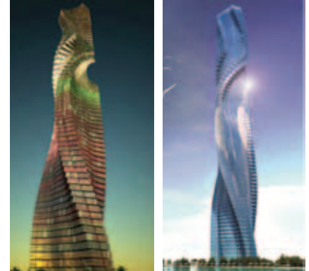
الشكل 05: تغيير شكل المبنى باستمرار بسبب إمكانية الدوران لكل طابق بشكل مختلف
